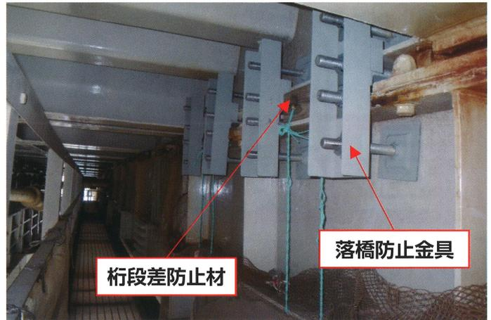
②落橋防止金具による応急措置状況
