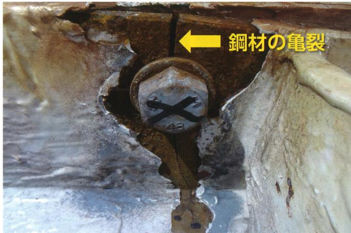
①伸縮装置の腐食状況(路面裏側)
